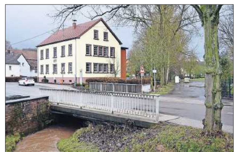
Die Brücke über den Bundenbach zwischen Kirche und Dorfgemeinschaftshaus in Oberauerbach muss saniert werden.
