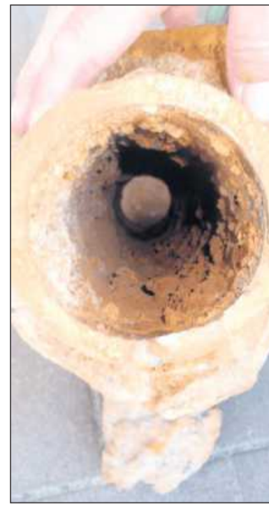
Das Rohrsystem stammt aus den 1930er Jahren. Die Rohre sind mit starken Ablagerungen belegt und genügen nicht mehr dem heutigen Standard. Deshalb werden ab heute die Haupt- und Nebenleitungen in der Weinstraße erneuert, die für drei Monate halbseitig gesperrt wird. Die Umleitungsstrecke über die Umgehung ist aus unserer Grafik ersichtlich.
